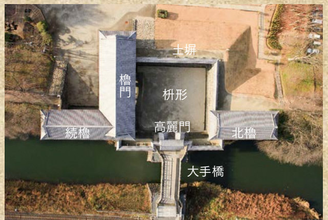
上空からみた二ノ丸東大手門
