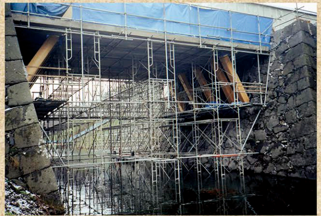
大手橋復原工事の様子
