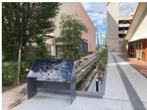
七日町第6ブロック北御殿堰整備事業(令和5年度)
