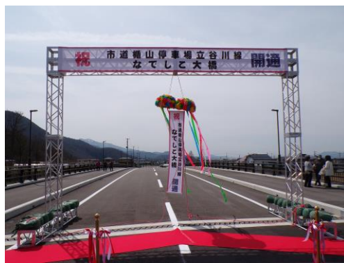
市道楯山停車場立谷川線「なでしこ大橋」開通 ～道路ネットワーク強化～
