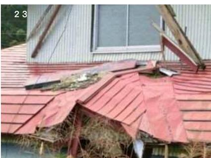
著しい変形と樋などの破損
