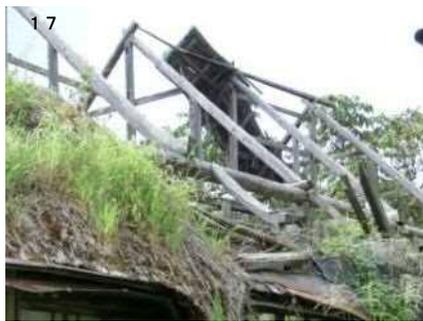
構造部材の大規模な損傷
