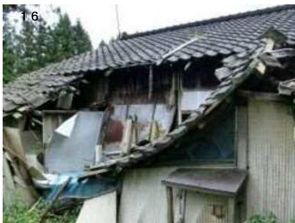
構造部材の大規模な損傷
