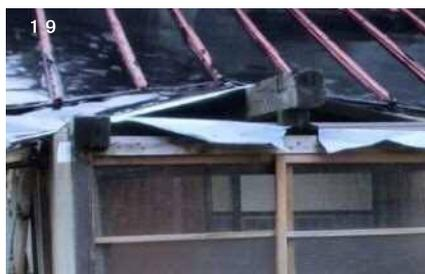
構造部材の大規模な損傷
