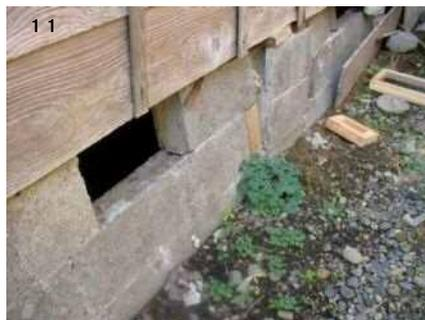
基礎に著しい損傷と傾斜
