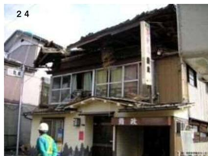
屋根が著しく破損している
