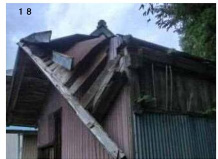
構造部材の大規模な損傷
