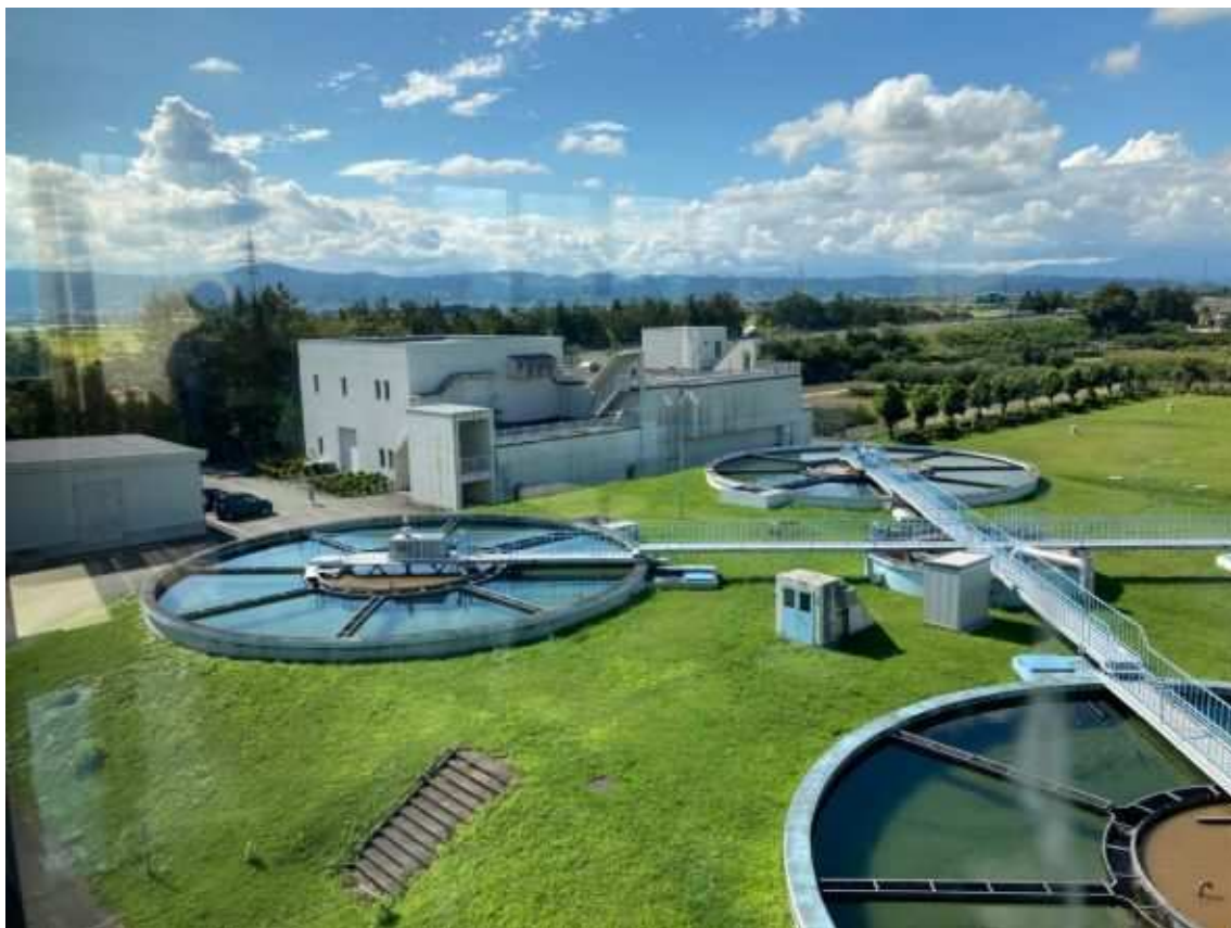
(高速凝集沈殿池と高度処理棟)
