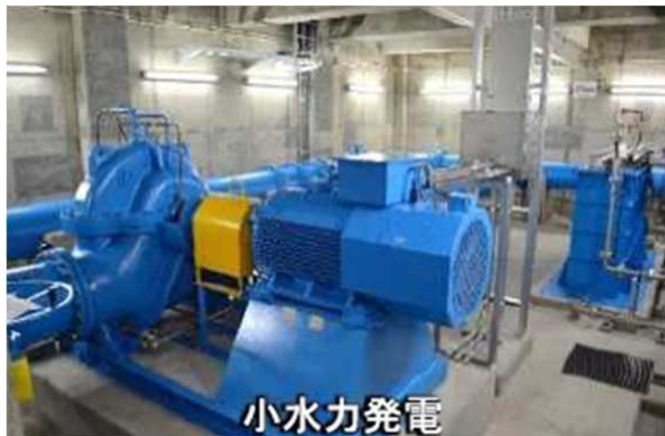
(松原浄水場小水力発電装置)
