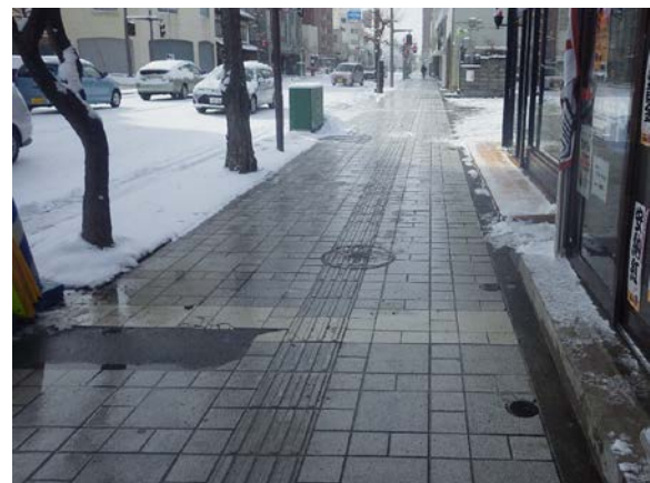
地下水熱による無散水消雪道路
