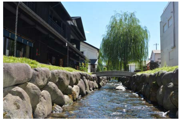
山形五堰（御殿堰）
