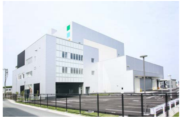
エネルギー回収施設(立谷川)
