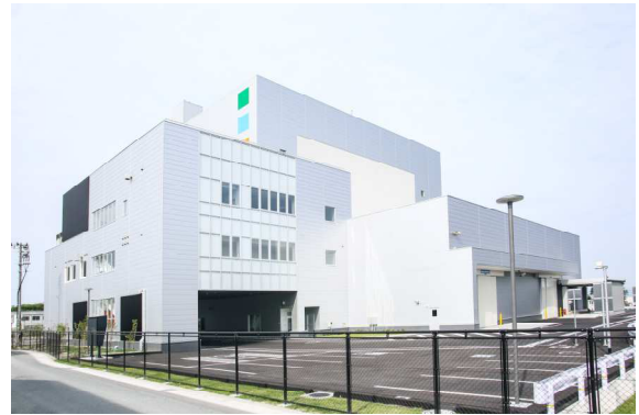
エネルギー回収施設(立谷川)
