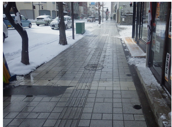
地下水熱による無散水消雪道路
