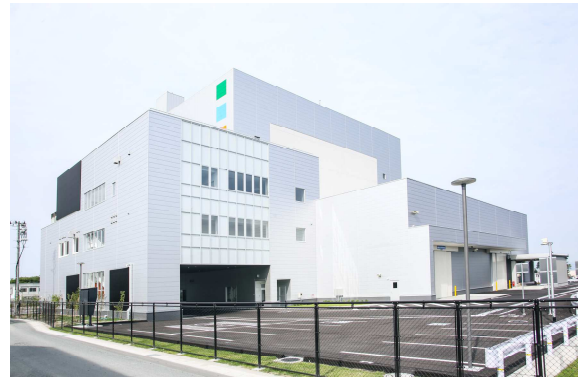
エネルギー回収施設(立谷川)
