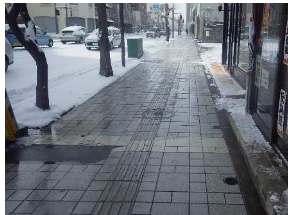
地下水熱による無散水消雪道路
