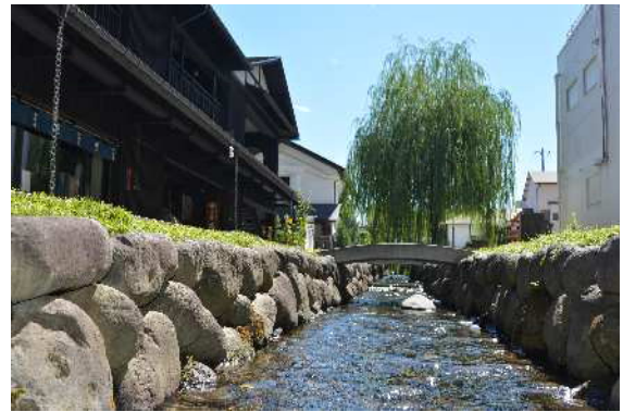
山形五堰（御殿堰）
