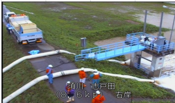
7月10日6:30 志戸田 (ポンプ車稼働 4:20~6:45)
