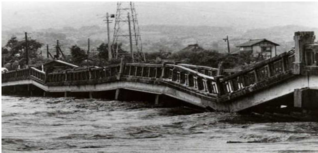
昭和42年8月 須川の増水によって損傷した門伝橋(大字沼木)
