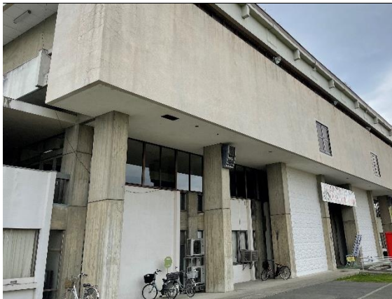
山形県体育館・武道館
