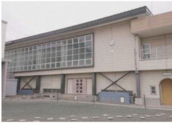
▲天井改修工事を行う第七小学校体育館
