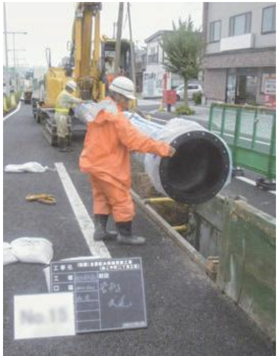
▲順次進められる配水管の耐震化工事
