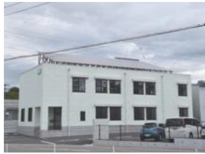
▲ZEBを導入した民間施設
