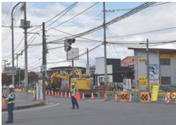
▲計画的に実施している道路維持作業
