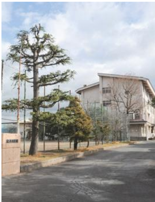
▲多目的教室を改修する金井中学校
