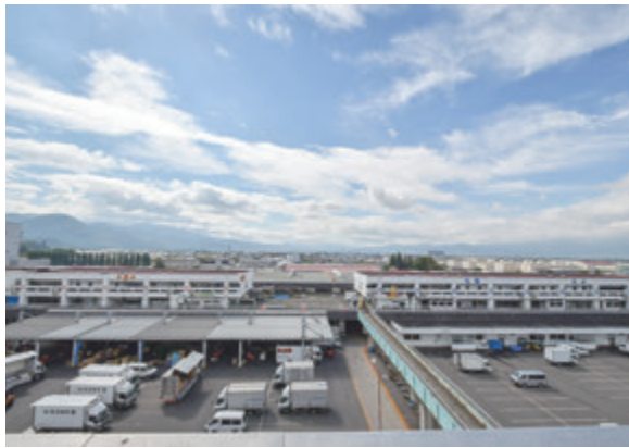
▲築44年が経過し、改修が必要な公設地方卸売市場
