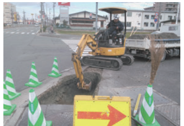
▲安全・安心の確保に向けた道路工事
