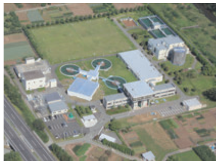
▲更新をひかえる見崎浄水場
