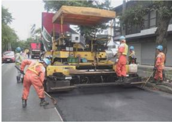
▲生活環境のさらなる向上を図る市道の舗装工事
