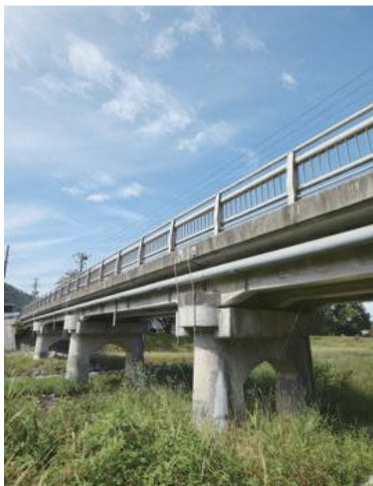
▲補修工事を実施した二本堂橋
