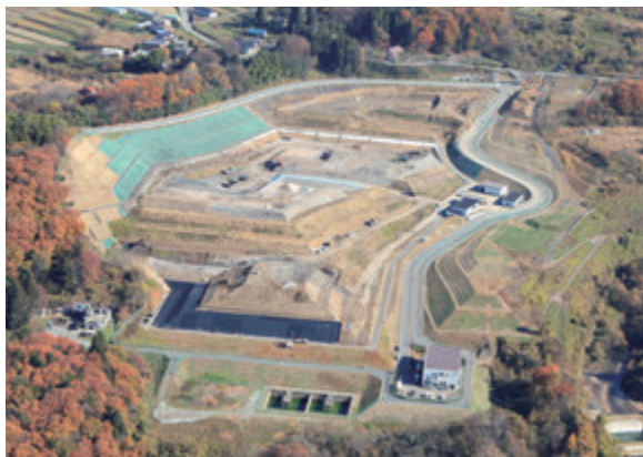
▲集中豪雨への対策工事を行った上野最終処分場
