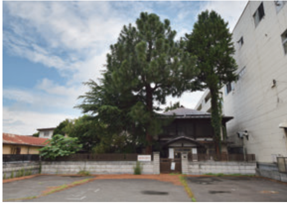
▲街のにぎわい拠点として活用が期待される旧木村邸
