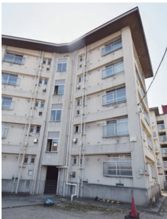
▲耐震改修で入居者も安心
