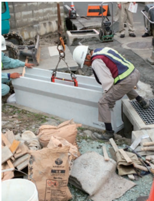
▲技術革新が進んでいる側溝・水路
