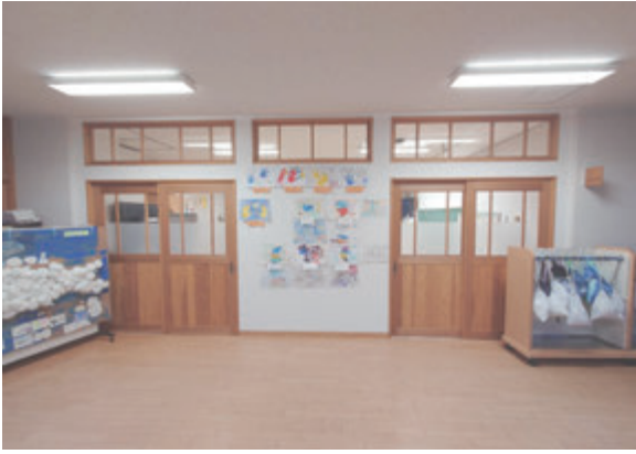
▲間仕切りを設置した小学校教室
