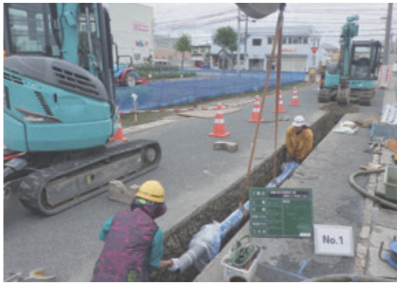
▲安全・安心な水道を目指して水道管を更新
