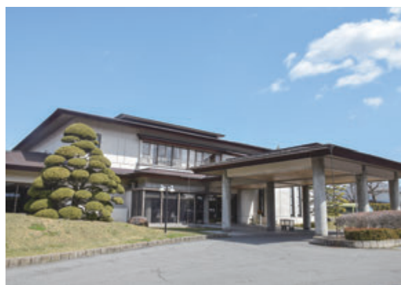
▲昭和59年の竣工から40年以上が経過している現在の斎場
