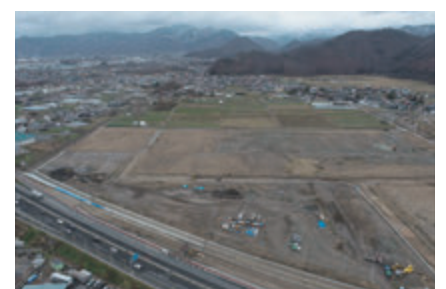
▲造成中の山形北インター産業団地 第2期整備も期待
