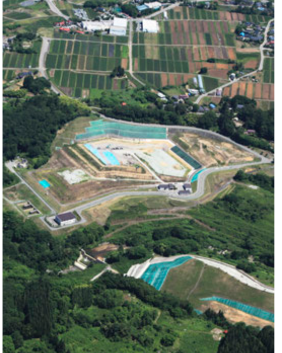
▲平成40年頃まで埋め立て可能な上野最終処分場
