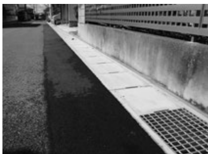
▲道路の維持補修工事で整備した側溝
