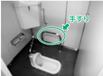
▲使用者に配慮したトイレ改修を
