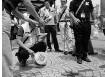
▲歩道の破損を市役所へメールで情報提供
