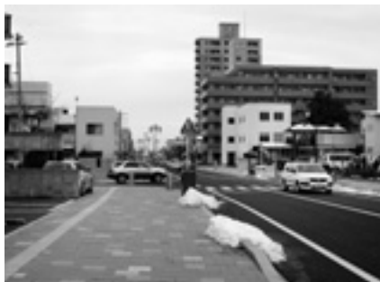
▲2車線化や歩道整備が行われた新築西通り二口橋線
