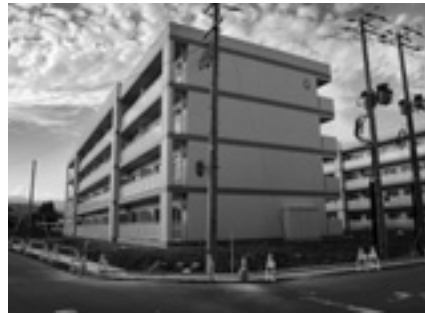
▲新たにG棟が完成する市営南山形住宅
