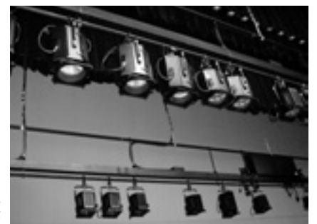
▲中央公民館の照明改修で利用者増加を期待
