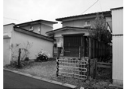
▲建設から40年以上経過している済生館公舎
