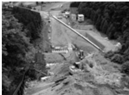
▲改修が進む蔵王ジャンプ台
