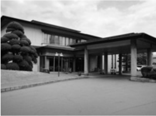
▲指定管理への移行でサービスの向上が期待される斎場
