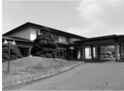
▲建設から30年以上が経過している山形市齋場
