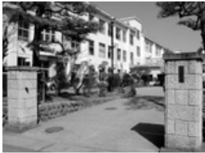
▲改築工事に着手する第五中学校
