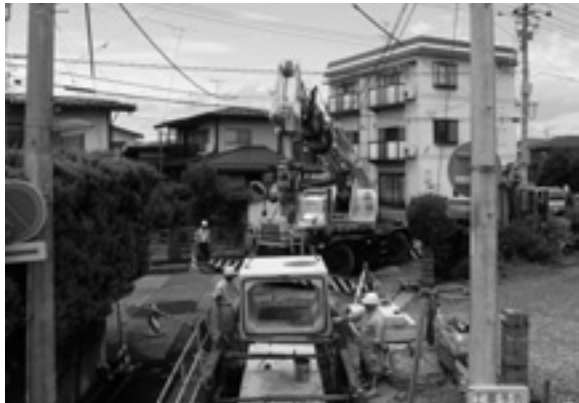
▲大雨による被害を防ぐ雨水管工事
