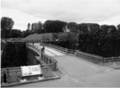
▲着々と工事が進められる山形城跡の復原工事
