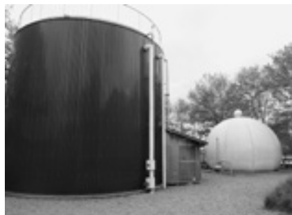
▲生ごみなどでエネルギーをおこすバイオマスシステム
