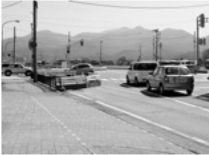
▲早期整備が望まれる馬見ヶ崎橋周辺
