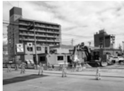
▲公契約条例制定で活力ある公共工事を
