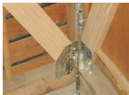
▲耐震改修の例(筋かい金物補強)
