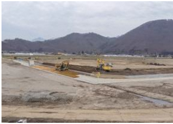
▲分譲に向けて造成工事施工中
